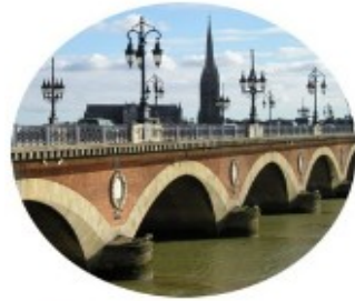
Pont de pierre à Bordeaux
